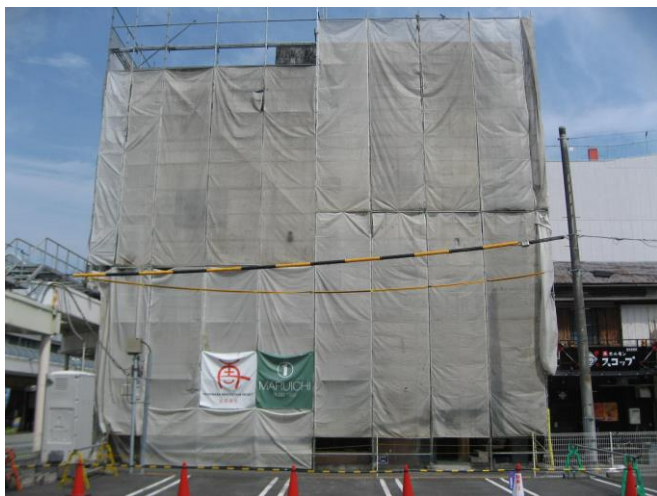
改修工事が進む吉原商店街の「マルイチビル 1962」
